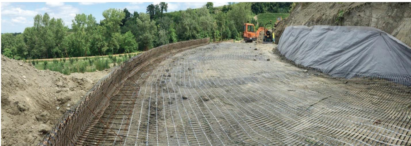
STRUTTURE DI SOSTEGNO ECOCOMPATIBILI IN TERRA RINFORZATA
