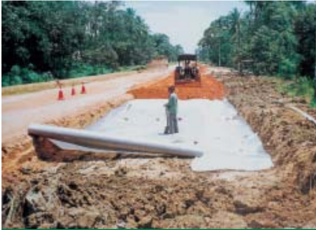
Costruzione di una nuova strada (Malesia)
