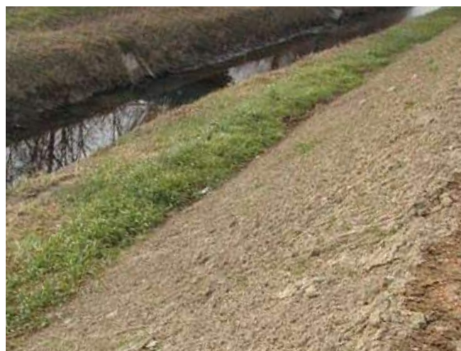
Ricoprimento con terreno
