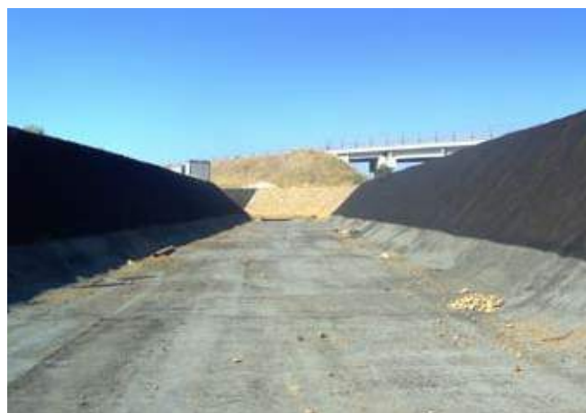
Posa dell'Enkamat® 7220 lungo le scarpate
