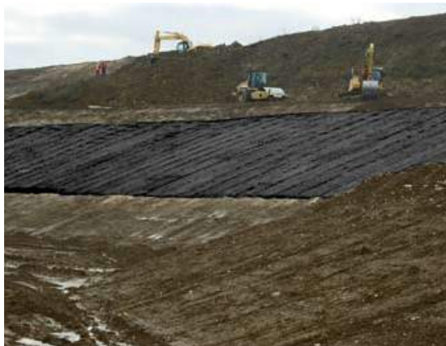
Posa dell' Enkamat® 7020 su pendio
