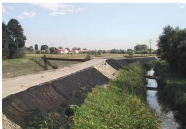
Scarpata arginale Posa dell'Enkamat® prima del ricoprimento con terreno
