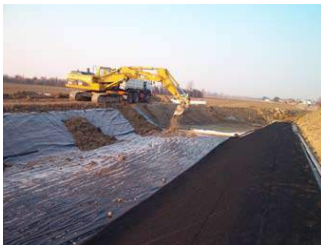
Canale di bonifica Posa dell'Enkamat® 7010W
