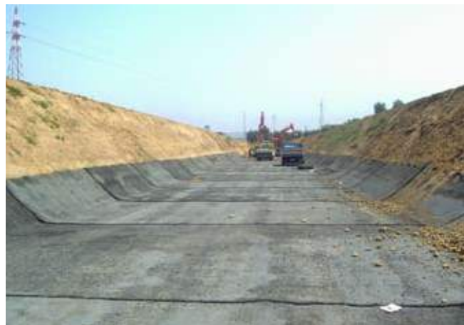
Posa dell'Enkamat® A20 (preintasato) sul fondo
